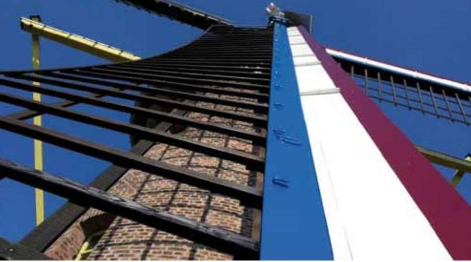
▲ Alle kleurvlakken en kenmerkende accenten brachten de schilders terug in de originele staat.
