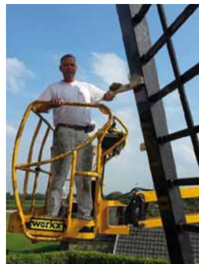
▲ Met verreikers en hoogwerkers werd het schilderwerk op hoogte uitgevoerd.
